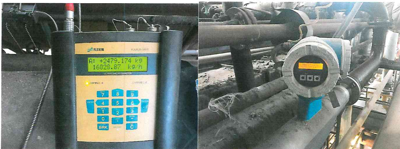
Рисунок 2. Подключение к расходомеру и сравнение показаний
